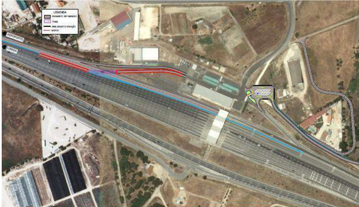
Figura 1- Separação de vias da praça de portagem da A12, no sentido Sul/Norte, para o Aeroporto do Montijo e para Lisboa
